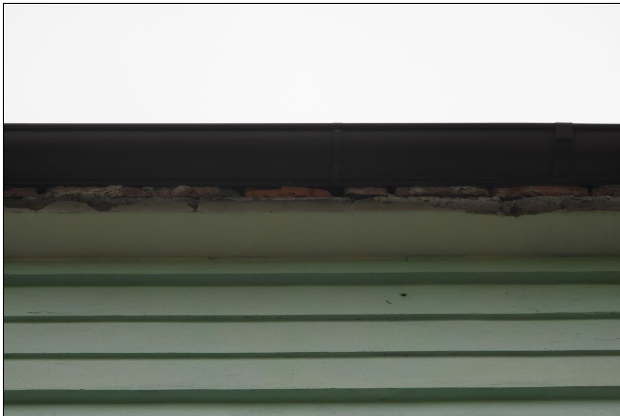
Netěsnosti nad malou římsou za okapem v oblasti vnější části pozednice.
